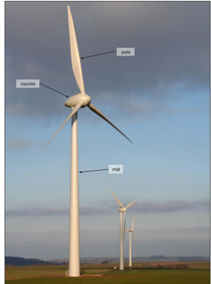
FIGURE 1 : PRINCIPAUX CONSTITUANTS D'UNE ÉOLIENNE
